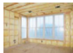
天井・壁等の断熱改修工事
